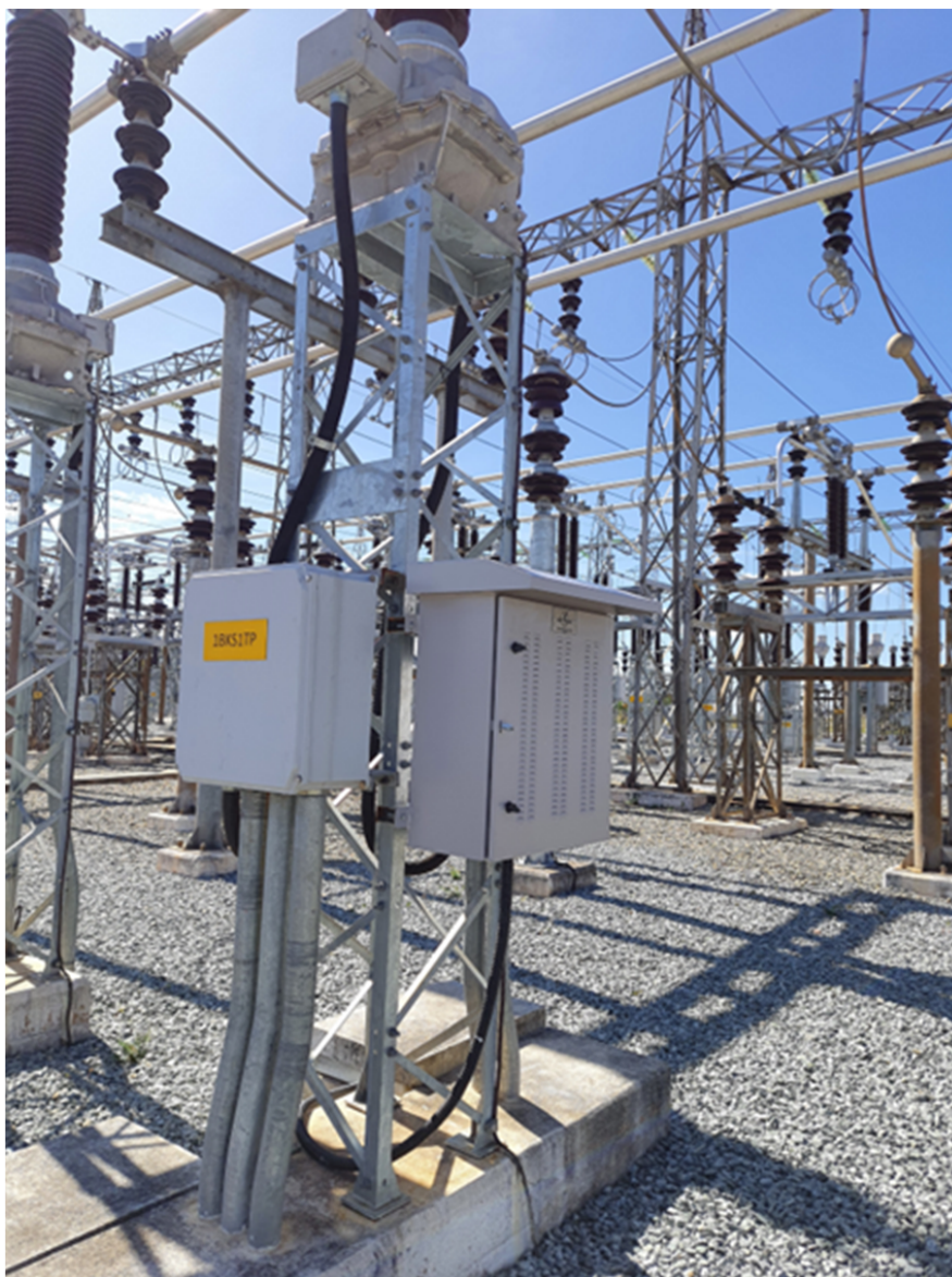
Figura 7 – Painel METP montado na estrutura do TP
